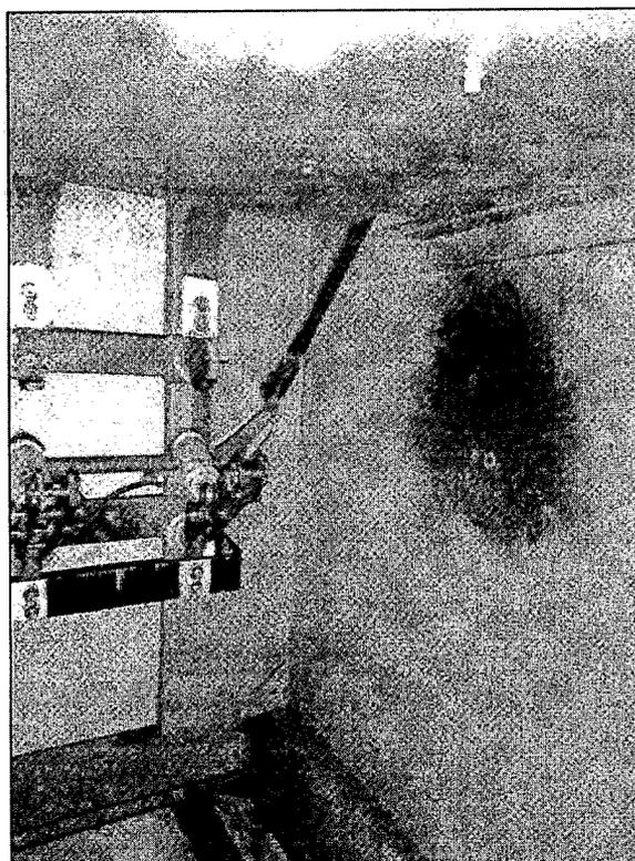
Очищение изоляторов без снятия напряжения с токоведущих частей/без применения специальных устройств (нарушение п. 40.4 ПОТЭЭ).
